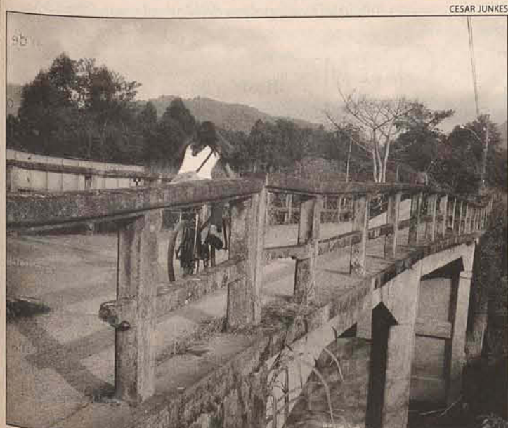
Nova ponte vai substituir estrutura usada por ciclistas e pedestres
