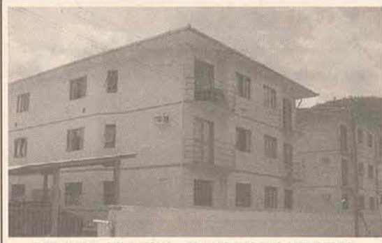
REF: 1035 - VILA NOVA - ED. JARDIM DAS MERCEDES. CONTENDO: 2 DORM., SALA, COZINHA, BANHEIRO, LAVANDERIA, GARAGEM, PLAYGROUND, SALÃO DE FESTA. R$ 28.000,00 MAIS PARCELAS DE 0,5 CUB.
