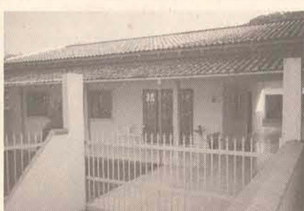
REF. 11 - Casa alvenaria 03 dormitórios, sala, copa, cozinha, banheiro, lavanderia, garagem, toda murada, apto nos fundos pequeno com quarto. R$ 95.000,00 (Negociável).
