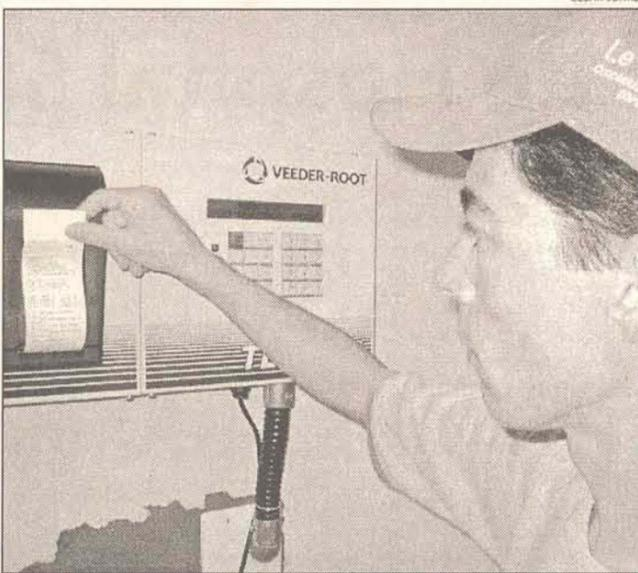
Com este aparelho o posto mede vazamento e a corrosão
