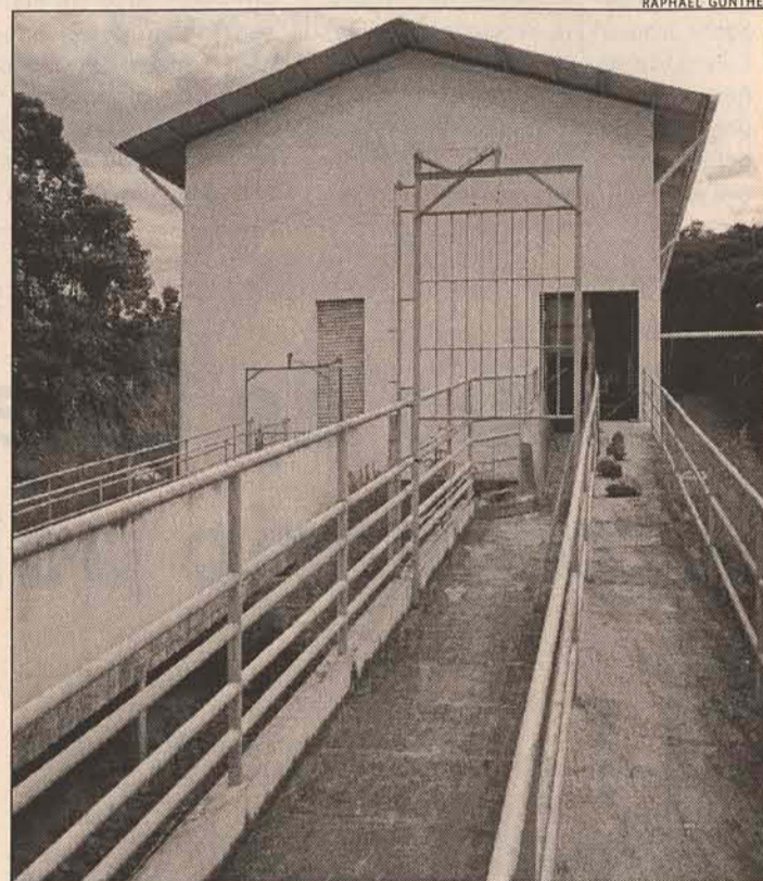
Abatedouro: obra abandonada, dinheiro jogado fora
