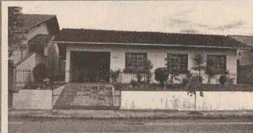
Ref. 543 - Casa de alvenaria na rua Irmão Leão Magno, nº 285 - Loteamento Champagnat, bairro Amizade. Dados: 03 dormitórios, sala, cozinha, banheiro, lavanderia, garagem, dispensa, toda murada. Valor: R$ 120.000,00.
