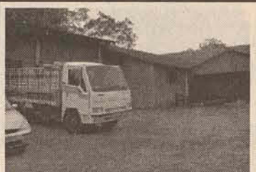
Cód. 791/05 GALPÃO JARAGUÁ ESQUERDO Área construída de 400m², área do terreno de 1.300m².
