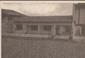
Cód. 788/05 CASA DE ALVENARIA SÃO LUIS Casa c/ +/- 121m², 02 qtos, 01 suite. Rua João Franzner.
