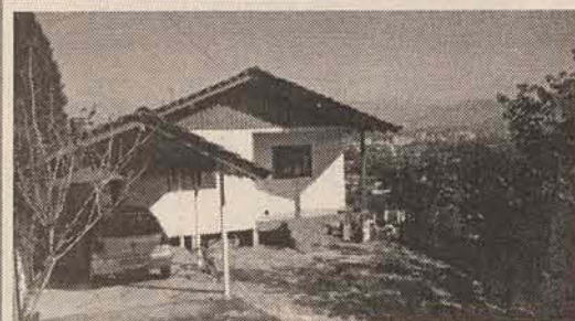
Ref. 565 - Casa de madeira na rua Maria Antônia da Silva Mascarenhas, bairro Iha da Figueira. Dados: 03 dormitórios, sala, cozinha, banheiro, lavanderia, garagem. Valor: R$ 42.000,00.
