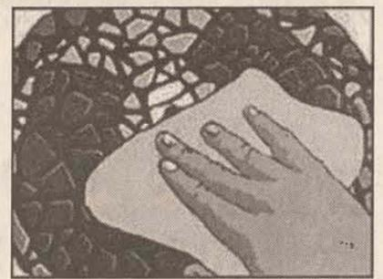
Ainda será necessário fazer o rejunte para que os espaços entre as peças fiquem preenchidos e a regularização da superfície seja total. Após o rejunte, a limpeza final deve ser feita com a massa já seca. Passe delicadamente uma esponja de aço e após, um pano seco.
