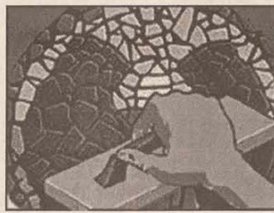
Após a colagem dos fragmentos respeitando o desenho do molde, a preocupação é com a regularização da superfície. Para isso poderá ser utilizada uma desempenadeira comum, batida sobre toda a extensão do mosaico, para que o mesmo fique bem regularizado, sem depressões ou ondulações
