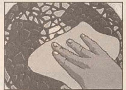
Ainda será necessário fazer o rejunte para que os espaços entre as peças fiquem preenchidos e a regularização da superfície seja total. Após o rejunte, a limpeza final deve ser feita com a massa já seca. Passe delicadamente uma esponja de aço e após, um pano seco.
