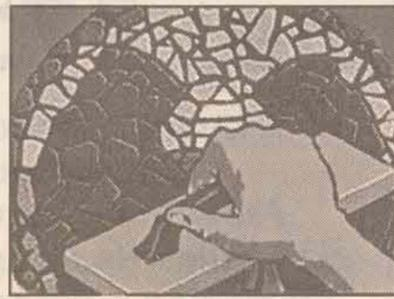
Após a colagem dos fragmentos respeitando o desenho do molde, a preocupação é com a regularização da superfície. Para isso poderá ser utilizada uma desempenadeira comum, batida sobre toda a extensão do mosaico, para que o mesmo fique bem regularizado, sem depressões ou ondulações.
