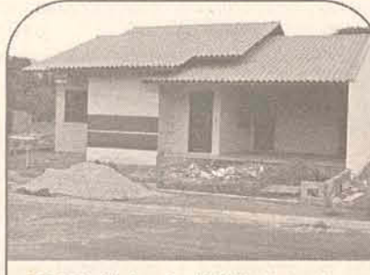
REF 2090 - Vila Rau - Rua 1181 - Lto. Grutmacher - Casa nova alv 115,00 m², 01 suite, 02 dorm, bwc, área serviço, garagem. Terreno 350,00. R$ 98.000,00. Podendo usar FGTS e financiamento.
