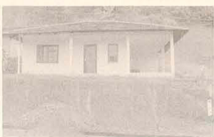
REF. 2015 - SÃO LUÍS - CASA ALV. C/ 94 M 2 . CONTENDO 2 QUARTOS, COZINHA, BANHEIRO, LAVANDERIA, VARANDA. TERRENO C/ 709 M 2 . R$ 47.000,00
