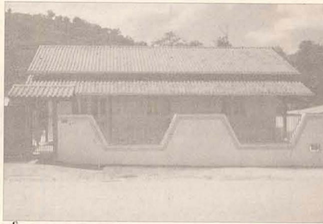
CASA ALV. - R. Artur Breithaupt, 943 - Lot. Firenze I Chico de Paula. Área total: 1.1319,00m 2 . Área construída: 114,00m 2 1 suíte, 2 quartos, sala, cozinha, bwc, e garagem
