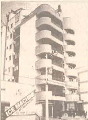
Vende: Apartamento (sem acabamento), contendo 03 dormitórios (sendo 01 suite), c/ área privativa 151,91 m 2 . Ed. Resid. Imperial (Centro)
