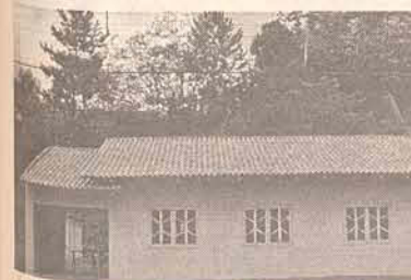
REF. 2427 - CASA ALV. C/ 85 M². CONTENDO 1 SUÍTE, 2 QUARTOS, SALA, COZINHA, BANHEIRO, ÁREA DE SERVIÇO, GARAGEM. TERRENO C/ 644 M². R$ 65.000,00
