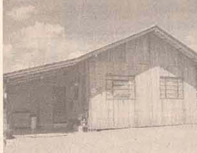
REF. 2036 - CHICO DE PAULA - CASA C/ 67 M². CONTENDO 2 QUARTOS, SALA, COZINHA, BANHEIRO, ÁREA DE SERVIÇO, GARAGEM. TERRENO C/ 350 M². R$ 35.000,00
