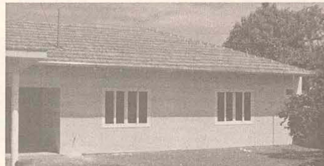
==VENDA== 5418 CASA - BARRA DO RIO CERRO II - RUA 1009 - PROXIMO DA CHOCO-LEITE - ÓTIMA CASA DE ALVENARIA COM 160,00M2, TODA MURADA, 01 SUÍTE + 01 QUARTO, SALA, COPA, COZINHA, LAVANDERIA, BWC, GARAGEM PARA 02 CARROS Área do terreno 770,50 m2 Área Beneficiarias 160,00 m2 Preço venda: 75,000,00
