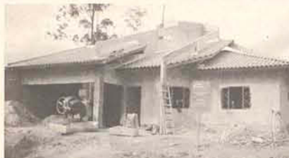
Ref 1156 CASA NOVA - AMIZADE , Lot. BlumengartenII, Casa em fase de construção com 93,00m2. Valor R$ 89.000,00.
