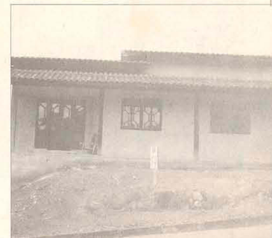
Casa na José Naloch - bairro São Luís, com 135,00m 2 - 03 quartos, sala, cozinha, lavanderia, banheiro, copa - (semi-acabada) -
