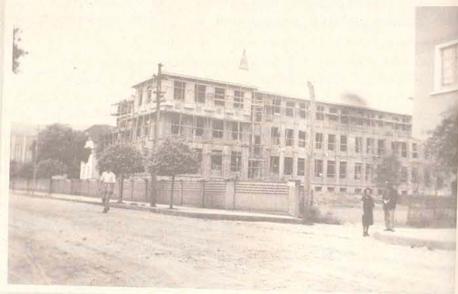
Construção do novo prédio do Colégio São Luís, em 1940
