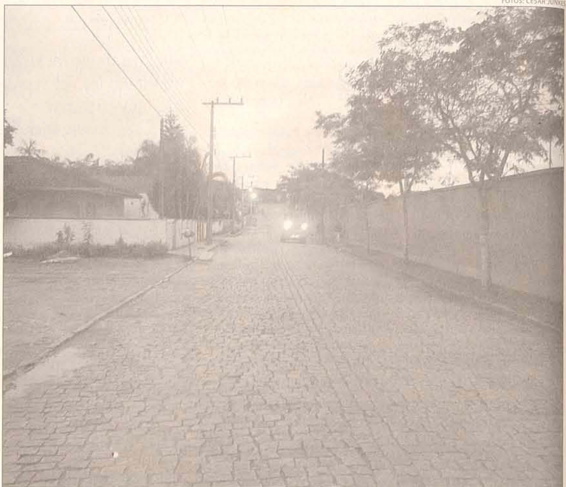
Na Rua Guilherme Gielow não será permitido o estacionamento e servirá apenas de acesso a pedestres
