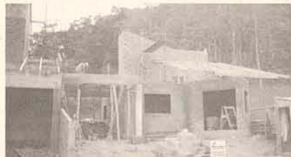
CASA NOVA - AMIZADE, Lot. Jardins das Acácias, Casa em fase de construção com 142,00m 2 . Valor R$ 119.000,00
