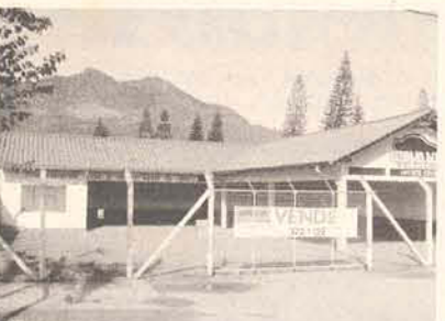
REF 3017 - R: PREF. WALDEMAR GRUBBA - VIEIRA - TERRENO 338,20 M² - EDIFICADO COM GARAGEM PARA REVENDA DE AUTOMÓVEIS COM 2 BWC, ESCRITÓRIO, 2 SALAS, DEPÓSITO. R$ 120.000,00
