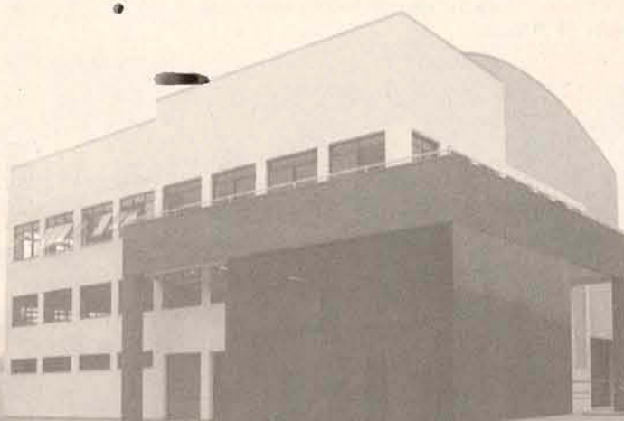
Jartec Automação Industrial Ltda - Rua João Planincheck
