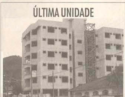
ÚLTIMA UNIDADE REF: 1002 - ILHA FIGUEIRA - APTO 108,34 M², 1 SUÍTE, 2 DORM, BANH, GARAGEM, SACADA, CHURRASQ. INDIVIDUAL., COM ELEVADOR. SEM ACABAMENTO INTERMO, SISTEMA DE CONDOMÍNIO. VALOR: 80 CUBS
