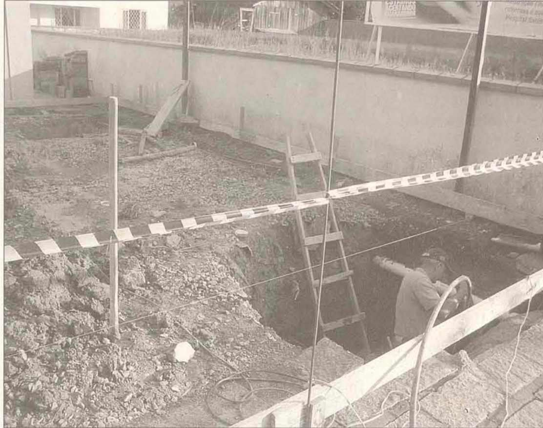
A atual diretoria da Aciag está ampliando a sede em mais 180 metros quadrados, em dois pisos
