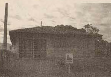
Ref 5483 - Estrada Nova - Casa Alv. c/ 135,26m2 - 04 dorm - 01 bwc - c/ piso cerâmico - Terreno c/ 539,00m2 - R$ 55.000,00
