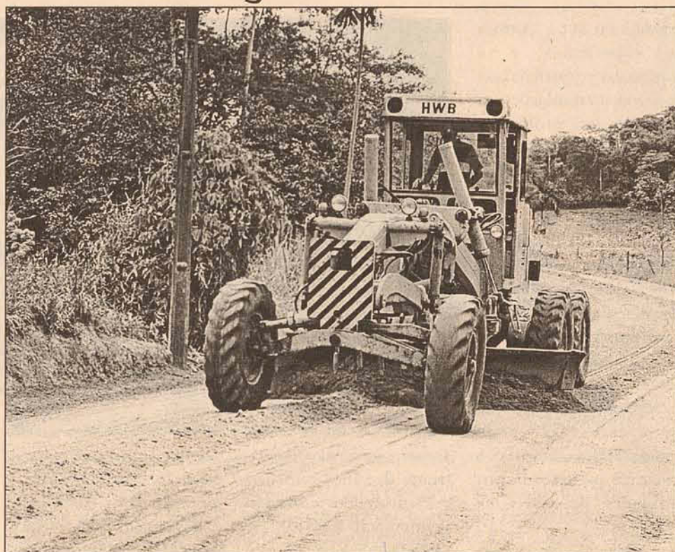
Patrolas fazem o alargamento da Rua Ricardo Fritze. Obras paliativas
