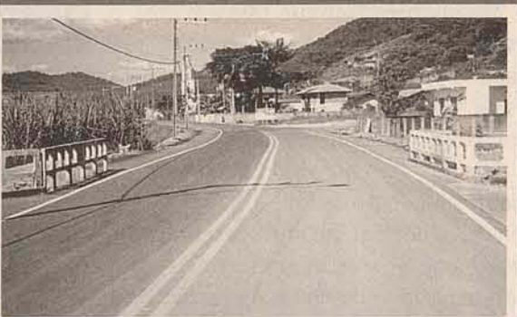
Pavimentação asfáltica da Rua Rio de Janeiro, no bairro Schroeder I
