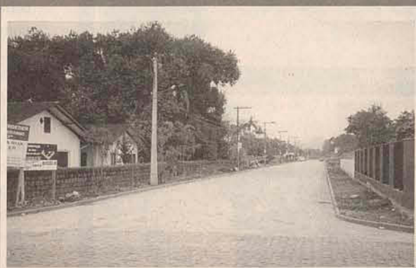
Pavimentação da Rua Germano Muller
