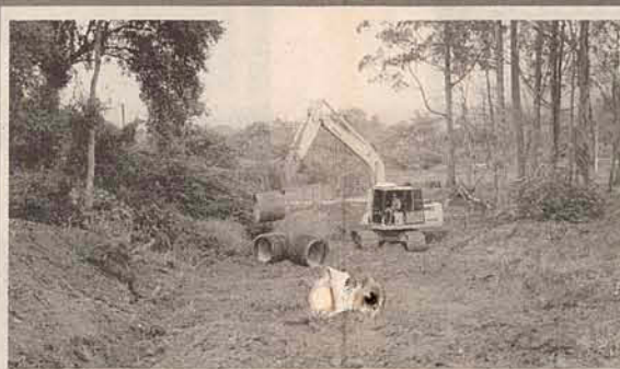
Aquisição da Escavadeira Hidráulica PC 150 permitiu a colocação de 14 mil tubos em parceria com os moradores de Schroeder
