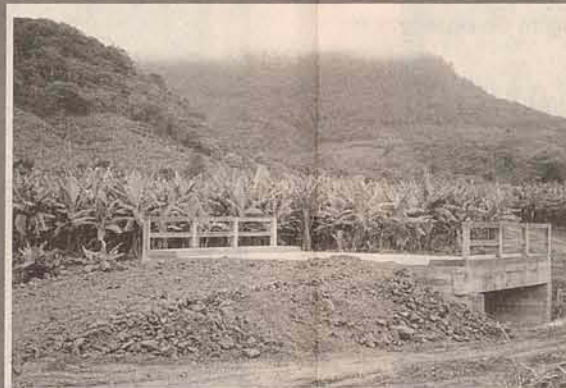
Construção da Ponte Rio Hern, finalizada em maio
