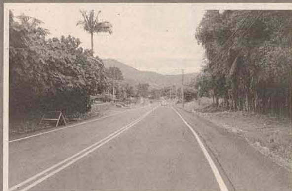
Pavimentação da Rua Barão do Rio Branco, concluída em fevereiro
