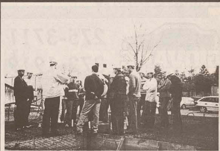
Acadêmicos de Arquitetura na obra do Le Petit: integração da teoria e da prática
