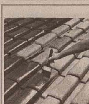
4. Comece pelas laterais da área a ser pintada, dando continuidade por toda a área. Para melhor resultado, você deve aplicar três demãos de tinta. Não esqueça de respeitar a diluição e tempo de secagem conforme as instruções da embalagem.
