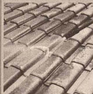
2. Para preparar a superfície, recomenda-se aplicar Novacor Telha sobre superfícies limpas e secas se necessário, lave, raspe ou escove para eliminar partes soltas, poeira, areia e manchas. Se as telhas apresentarem mofo ou fungo, remova-os com uma solução preparada em proporções iguais de água sanitária e água limpa.
