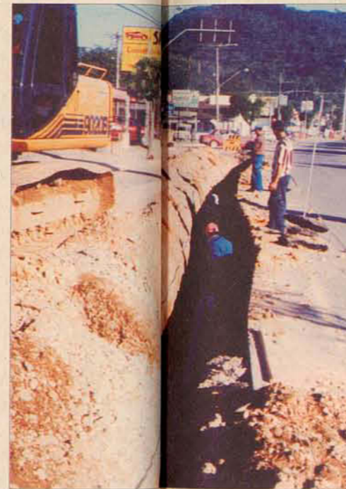
Implantação de esgoto na Rua Walter Marquardt
