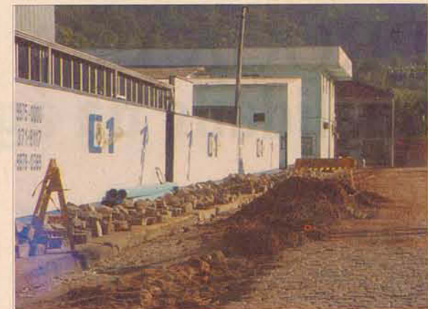
Rede de Água em execução na Rua Profº Irmão Geraldino Bairro Vila Lalaú
