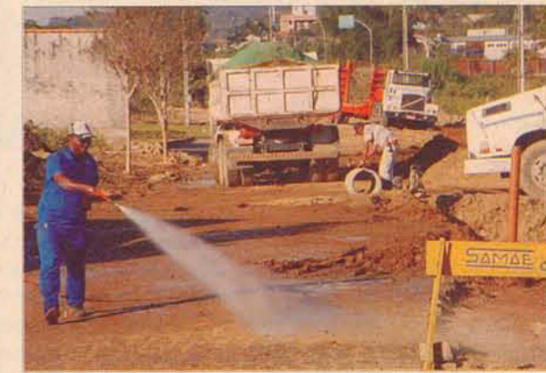
Obras de execução da rede de esgoto sanitário da Rua Marina Frutuoso
