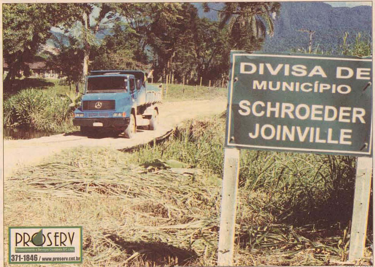
Pontilhão na divisa entre os municípios de Joinville e Schroeder, na localidade de Itoupava Açu não oferece segurança aos moradores do local, que reivindicam a construção de uma nova estrutura
