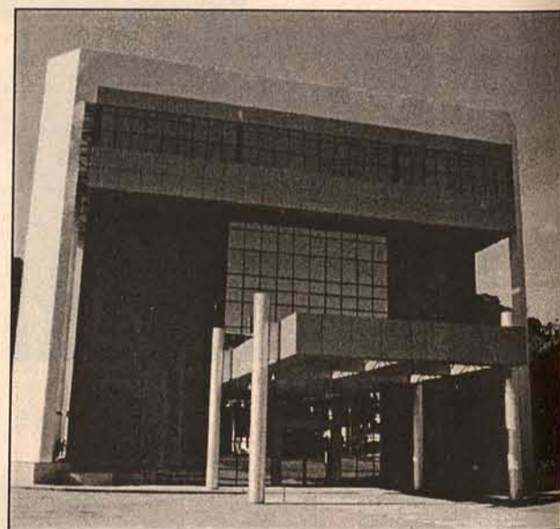
Centro Cultural espera verba para conclusão
