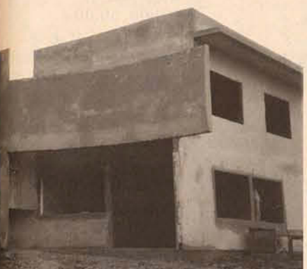
ESTÁ EM FASE FINAL DE ACABAMENTO RECURSOS DA COMUNIDADE
