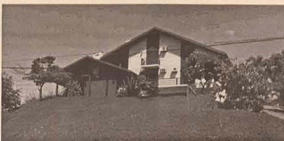
5171 CASA - CENTRO - R. CELSO HERMES ULRICH, SNº - 03 SUITES, 01 QUARTO, 03 BWC, SALA DE ESTAR, SALA TV, SALA DE JANTAR, SALA DE JOGOS, ESCRITORIO, ADEGA, COPA, COZINHA, LAVABO, DEP. EMPREGADA, GARAGEM 02 CARROS, CHURRASQUEIRA, PISCINA. 02 PAVIMENTOS, INTERIOR EM 03 NIVEIS. Área do terreno 1.700,00 m 2 Área Benfeitorias 500,00 m 2 Preço: 380,000.00
