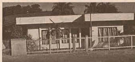
20 CASA ALVENARIA - AMIZADE - FREDERICO TODT - 03 QUARTOS, SALA, COPA/COZINHA, BWC, LAVANDERIA, GARAGEM. TERRENO 420,00 M2. Área do terreno 420,00 m2. Área Benfeitorias 120,00 m2. Preço: 47.000,00
