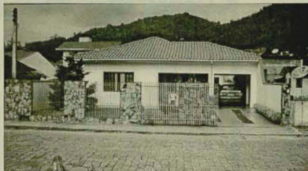
COD 131 - VILA NOVA - Casa em alvenaria medindo 235,61m 2 - Valor 135.000,00
