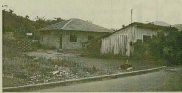
COD 105 - ILHA DA FIGUEIRA - Casa em alvenaria faltando acabamento - Valor R$ 27.000,00
