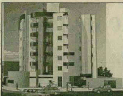
Edifício Marina em construção na
