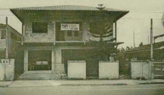
COD 122 - ÁGUA VERDE - Sobrado em construção - Valor R$ 65.000,00
