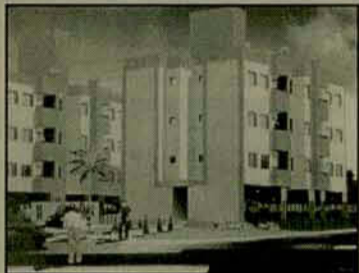
Residencial Santos Dumont Construção e Incorporação PROMA
