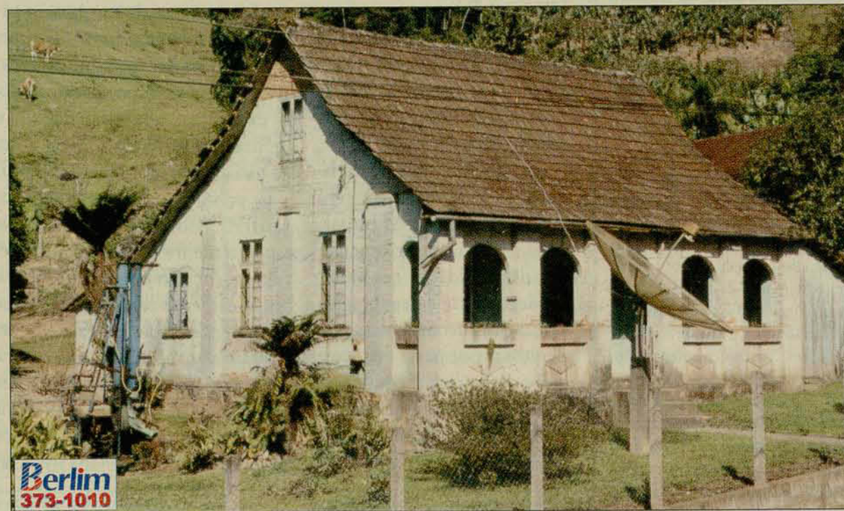
Residência construída em Corupá, com aproximadamente 130 anos, pode ser demolida.
