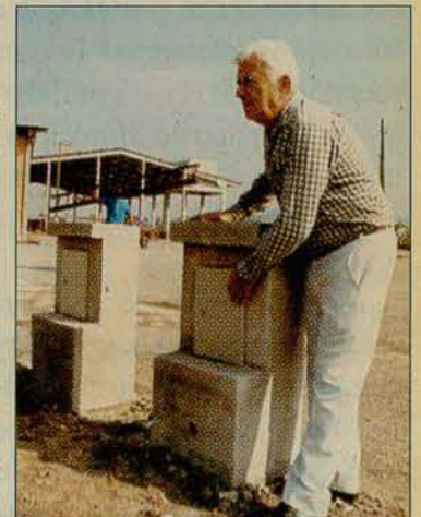
Expositores terão acesso fácil e seguro à energia elétrica
