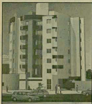
Edifício Marina em construção na Rua Marina Frutuoso
