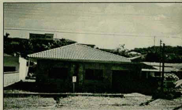
COD 071 - Ana Paula - estrutura para dois pisos - 1 suite, 2 quartos, sala, copa, cozinha, lavanderia, banheiro - Falta acabamento - Valor R$ 38.000,00
