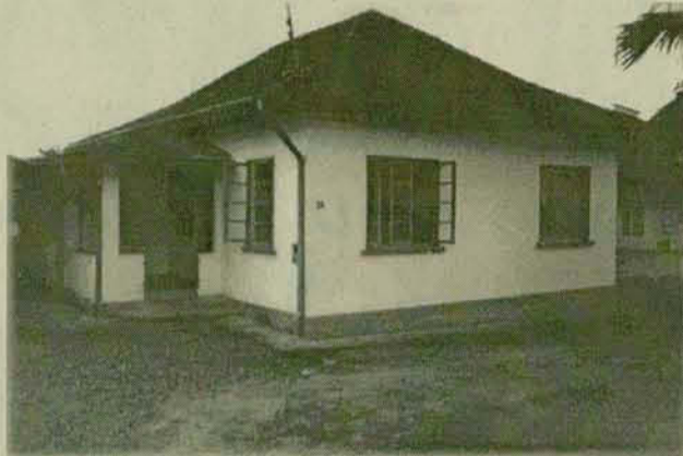
CZERNIEWICZ - R. Roberto Zilmann, 19 - 2 casas de alvenaria, terreno com 600m 2 , coz., lavanderia, 3 qtos, bwc e garagem. R$ 90.000,00
