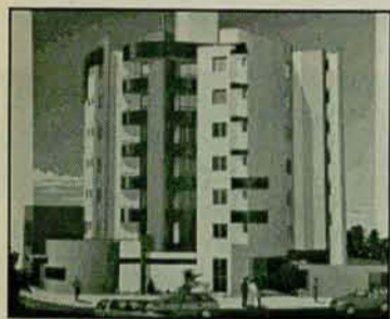
Edifício Marina em construção na Rua Marina Frutuoso
