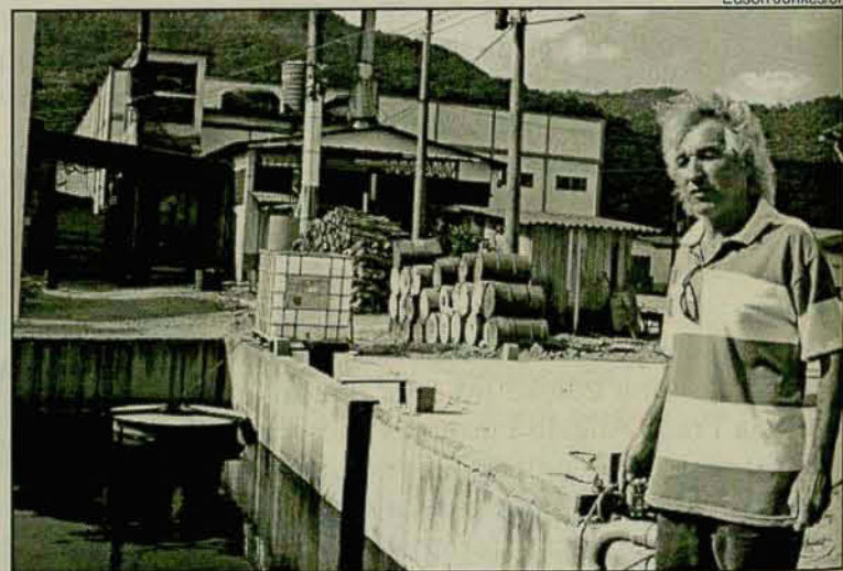
Prazo: Vieira garante conclusão da estação de tratamento em 90 dias
