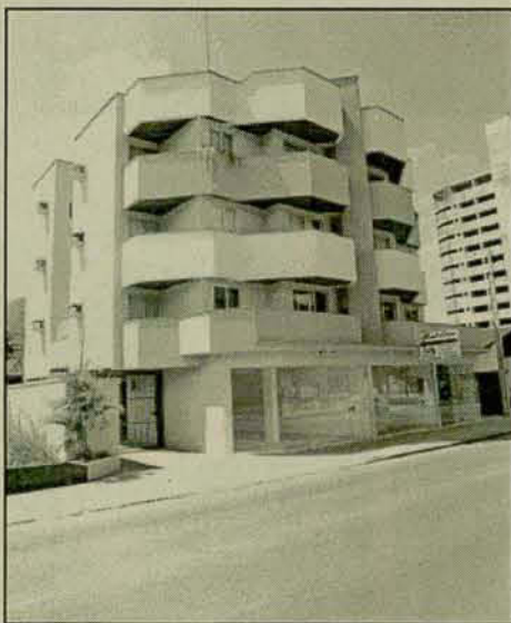
CENTRO - Edifício San
