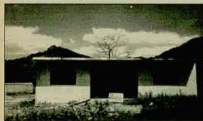
Cód. 493 - Casa nova (Fase de acabamento) de alv. c/ 100,00m 2 , contendo três quartos, bwc, cozinha, área de serviço e despensa. Extrutura p/ 2º piso. Terreno c/ 682,00m 2 . ILHA DA FIGUEIRA - R$ 35.000,00. (aceita veículo ou caminhão como parte do pagamento)
