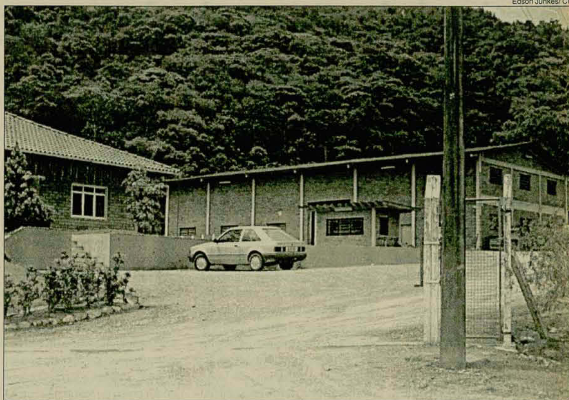
Sob fiscalização: empresa terá que emitir relatórios sobre o serviço de inertização, a cada 60 dias
