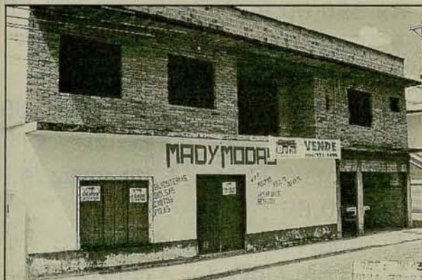
Ref. 2043 - NOVA BRASÍLIA - R. D. Antonia - sobrado residencial e comercial, em fase de acabamento, 264m 2 . R$ 56.000,00
