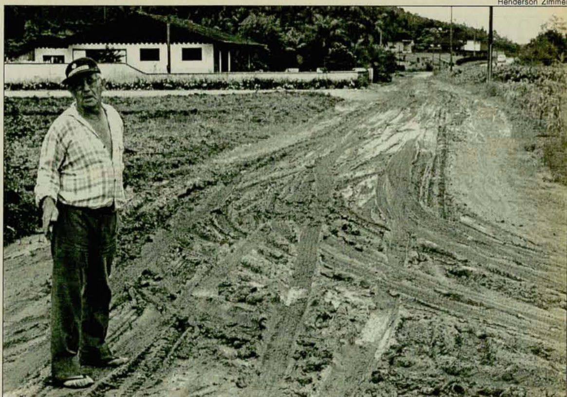
Situação: o que deveria ser macadame tornou-se lodo que os moradores precisam atravessar
