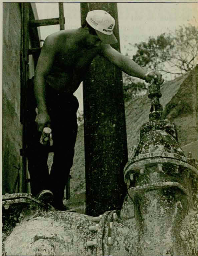
Reservatórios: a primeira parte da obra foi concluída esta semana
