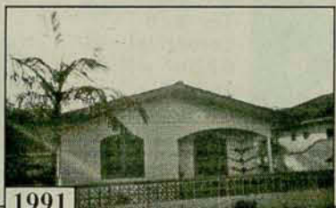
1991 Schroeder - Rua Pedro Hang - madeira c/ 3 quartos - R$ 28.000,00
