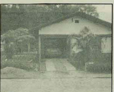
VENDE: Casa em alvenaria c/ 160,00m 2 , e terreno c/ 600,00m 2 - Rua Friedrich W. Sonnenhohl (Vila Lalau) - Preço R$ 45.000,00
