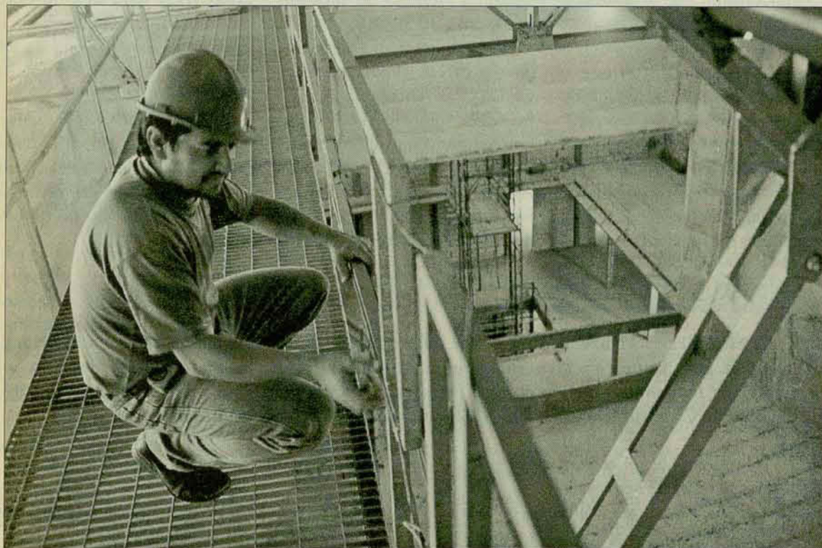
Obra: concluído o teatro para 240 lugares, Centro Cultural entra em fase final de construção
