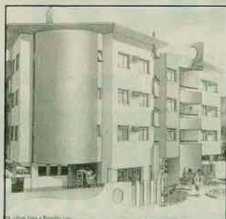
Em início de obra - Residencial Sunflower - R. José Emmendoerfer (Próx. a Marechal)
