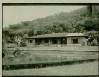
Casa em alvenaria c/ 340m², terreno com 2.000,00m² - próximo a Ferj - R$ 250.000,00
