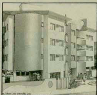
Em início de obra - Residencial Sunflower - R. José Emmendoerfer (Próx. a Marechal)
