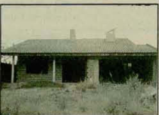
Casa em construção - Bairro Versailles - R$ 26.000,00
