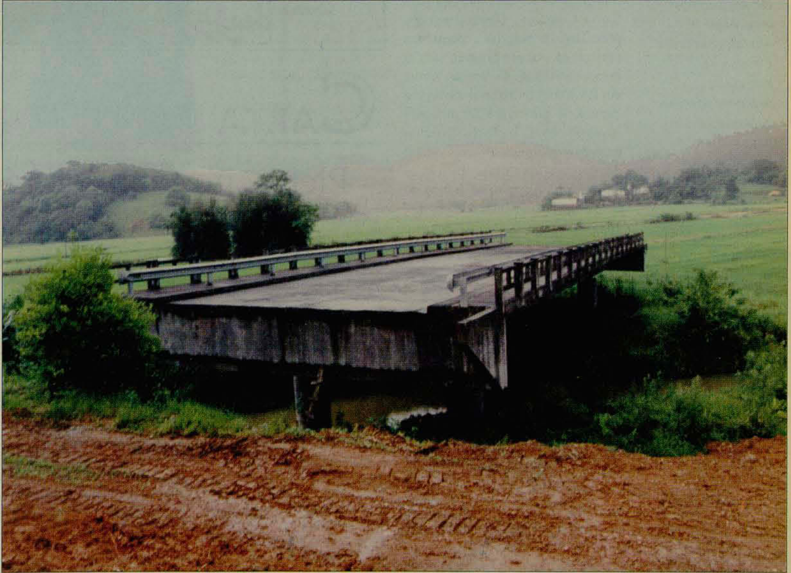
A espera: ponte construída no traçado da nova rodovia aguarda pela obra de pavimentação em meio aos arrozais. Página 10
