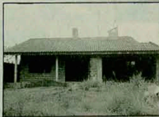
Casa em construção - Bairro Versailles - R$ 26.000,00
