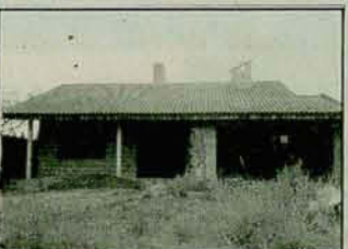
Casa em construção - Bairro Versailles - R$ 26.000,00
