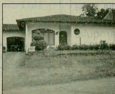
VENDE: Alvenaria c/ 180,00m 2 . Rua Guilherme Melchet - Corupá - R$ 75.000,00
