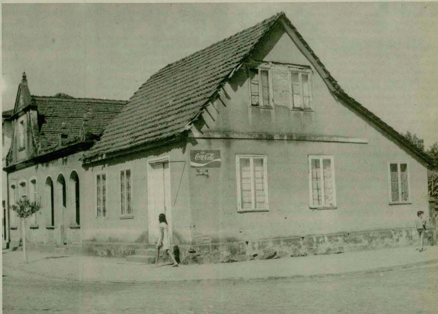
Rua Mal. Floriano Peixoto, esquina com a Pres. Epitácio Pessoa. Hoje, ali se encontra o prédio da Telesc
