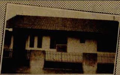
CASA ALVENARIA - Jaraguá Esquerdo, 3 qtoe, sala, coz., BWC, lavanderia, toda murada. Valor R$ 36.500,00
