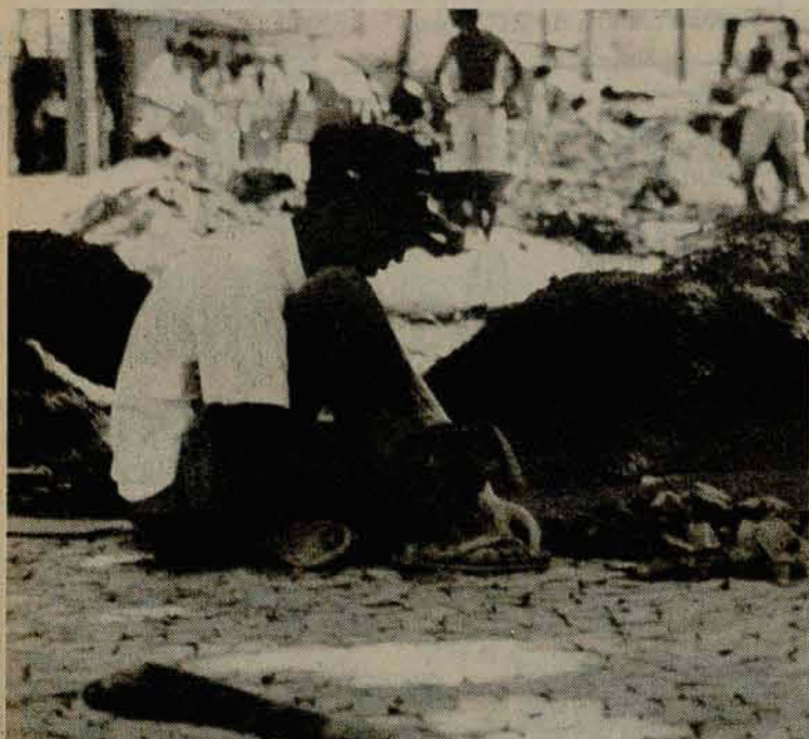
Colocação de petit-pavet entra na reta final
