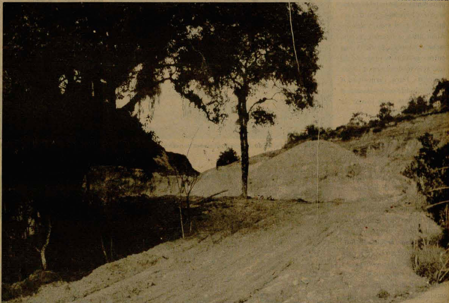
Secretaria de Obras retirava macadame em uma área de aproximadamente 10 mil metros quadrados
