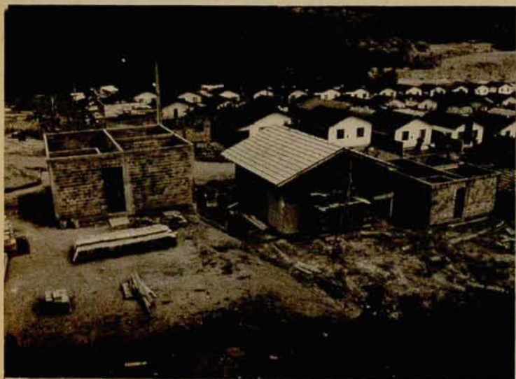
Já são 27 casas em regime de mutirão
