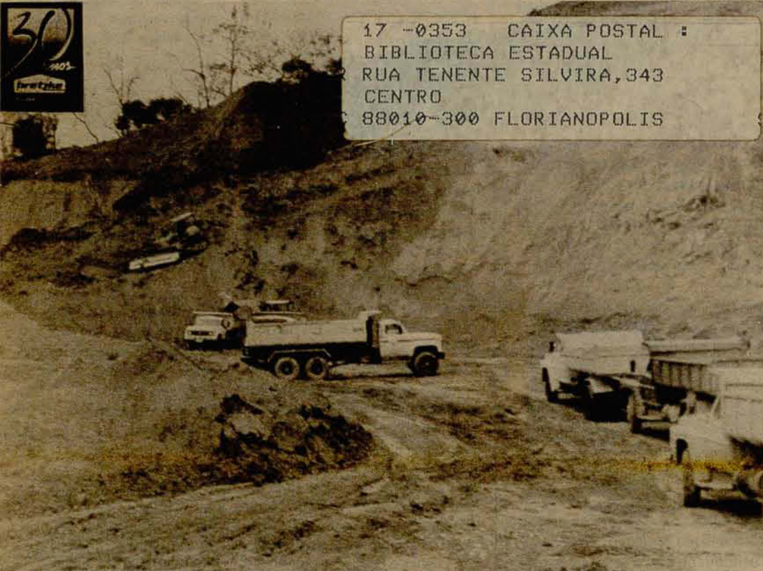
Terraplenagem da área já foi iniciada
